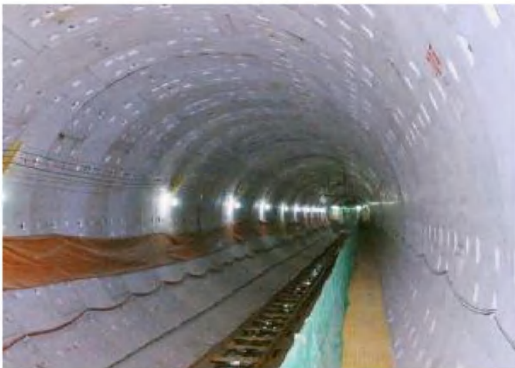
图 4.4.1-3 盾构法施工内部施工现场
