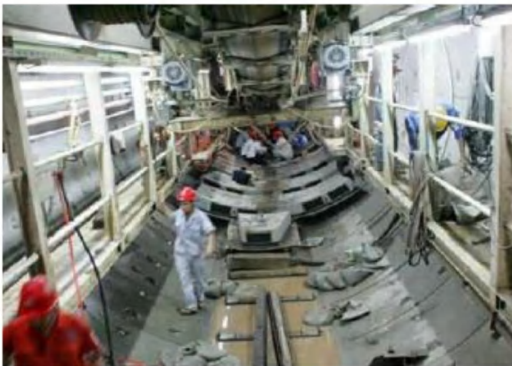
图 4.4.1-2 盾构法施工内部施工现场
