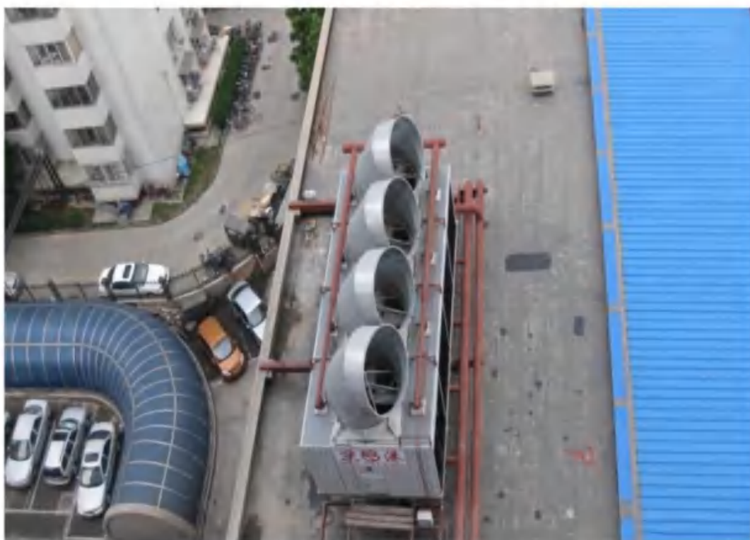
图 5.1.2-1 冷却塔导向消声器实施实例
